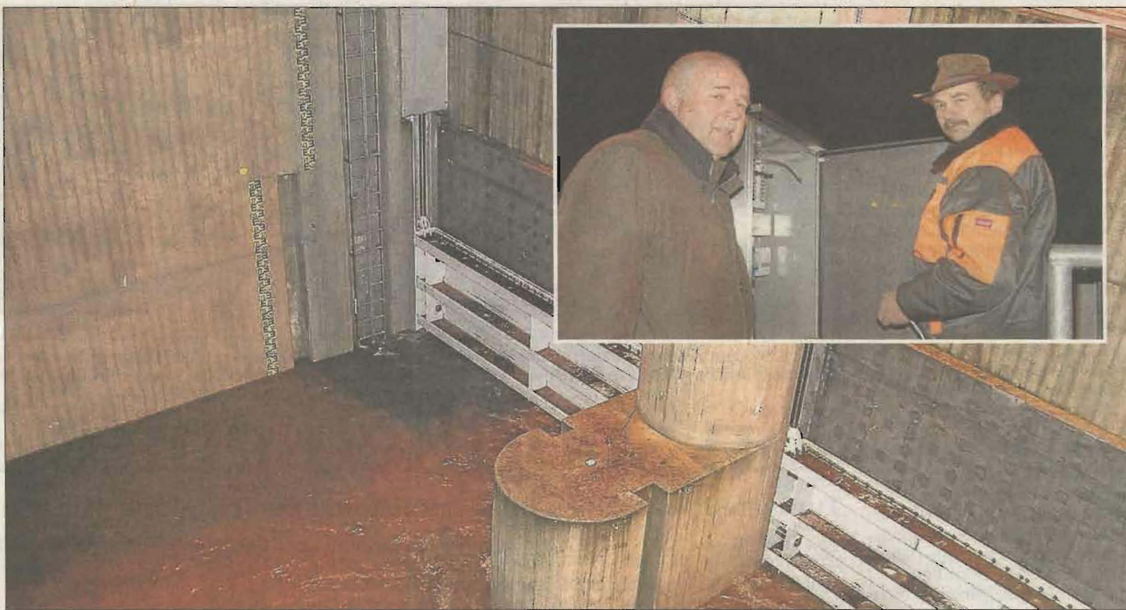
Blick ins Becken: Als Sonntag die Schotten heruntergelassen wurden, füllte sich das Rückhaltebecken mit Wasser. Bürgermeister Hartmut Linnekugel (kleines Bild links, zusammen mit Stauwärter Andreas Richter) hatte beim RP Kassel um die Genehmigung gebeten.
