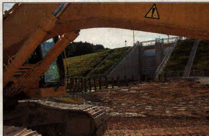
Bald fertig: Noch rollen die Bagger am Staudamm bei Ehringen. Zum Einweihungstag am 17. Oktober soll alles fertig sein.
