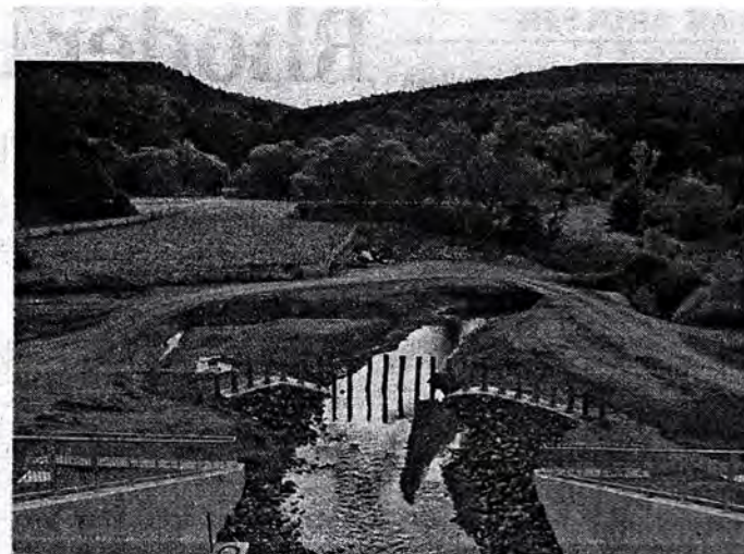
Ein harmlos plätschernder Bach ist die Erpe normalerweise. Doch wegen der immer auftretenden Hochwasser mit Todesopfern und hohen Schäden in den vergangenen rund 150 Jahren ist ein Staudamm bei Ehringen errichtet worden. Unser Bild zeigt von der Krone des Damms die Erpe mit den als Grobrechen dienenden Eichenstämmen vor dem Auslassbauwerk. (Foto: -ah-)
