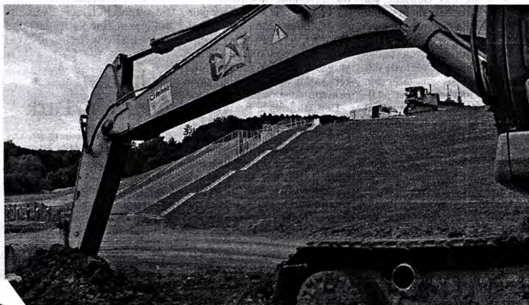
Zurzeit wird noch an einer Straße hinter dem Rückhaltebecken bei Ehringen gebaut. Diese dient ausschließlich Baumaschinen und Versorgungsfahrzeugen als Fahrstrecke. (Foto: -ah-)
