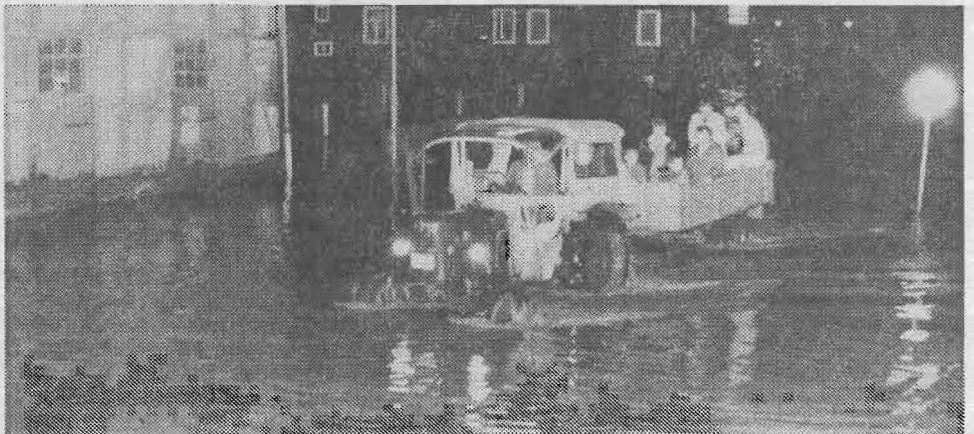
Nur hochrädige Fahrzeuge konnten sich in den bis zu einem Meter in den Straßen stehenden Fluten bewegen. Sie transportierten die Helfer zu ihren Einsatzorten.
